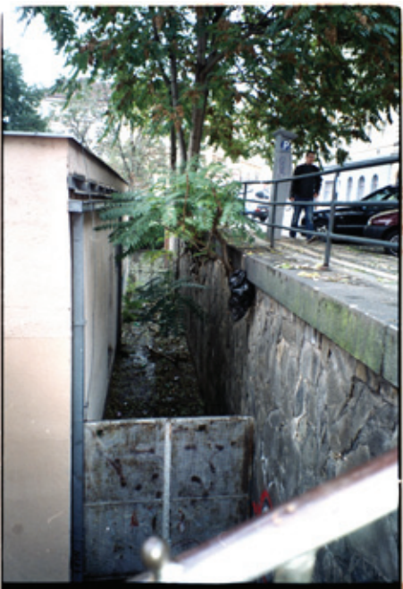
Kyklopské zdivo s náletovými stromy za trafostanicí
