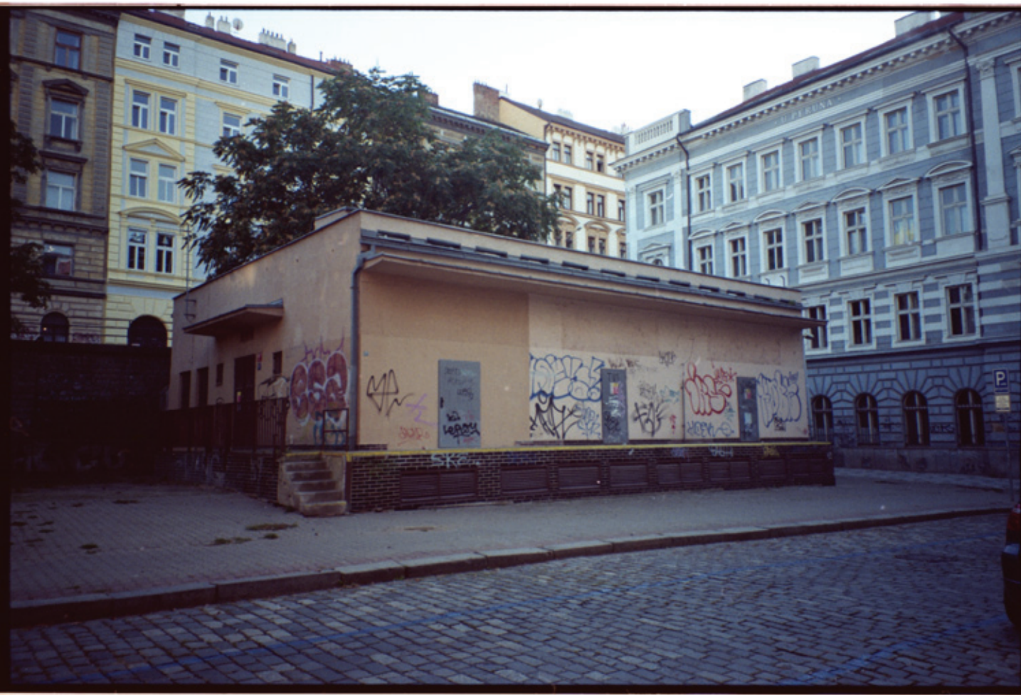
Trafostanice na Kostnickém náměstí
