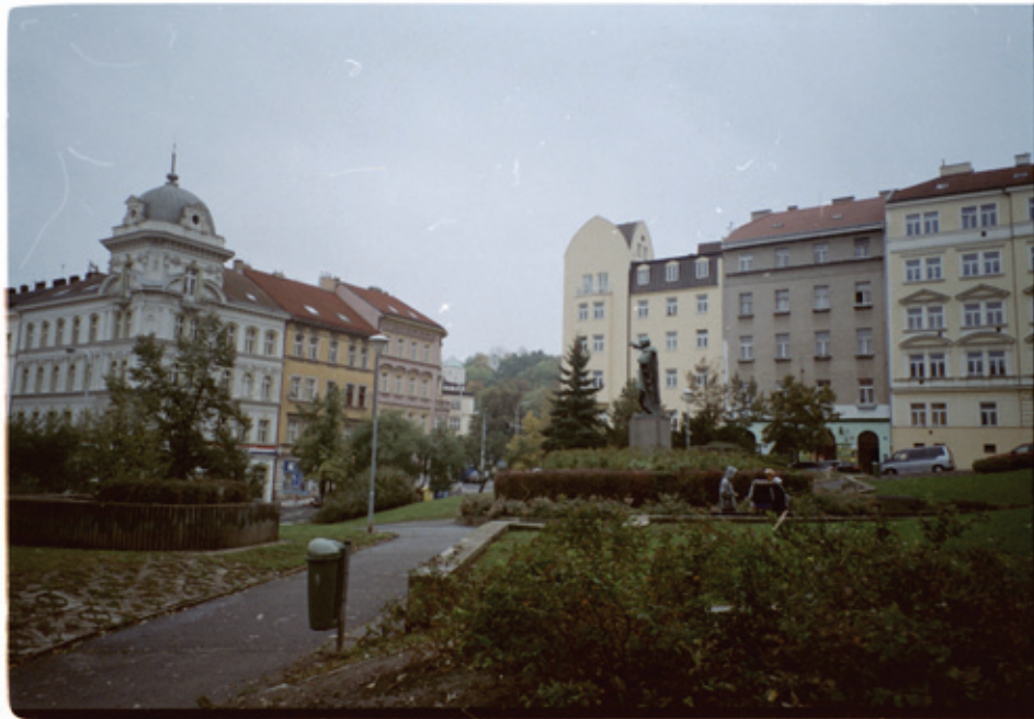
Havlíčkovo náměstí pohled od západu Vlevo výdech kolektoru.
